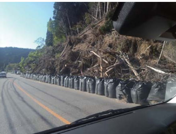
道路のがけ崩れを一時補修
